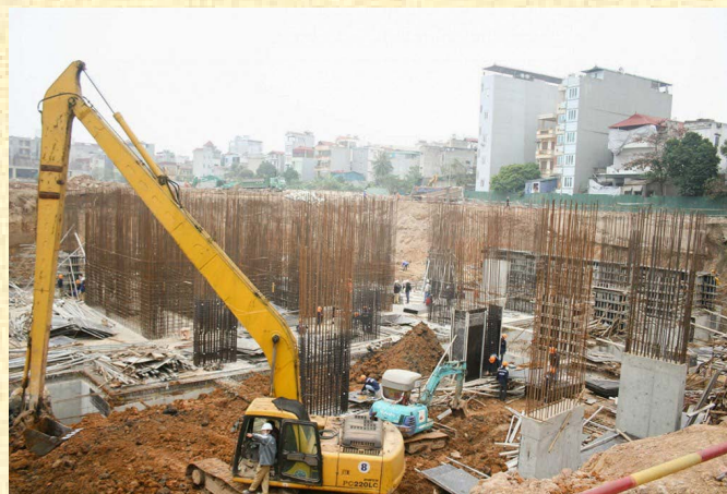
Một dự án chung cư đang xây dựng
